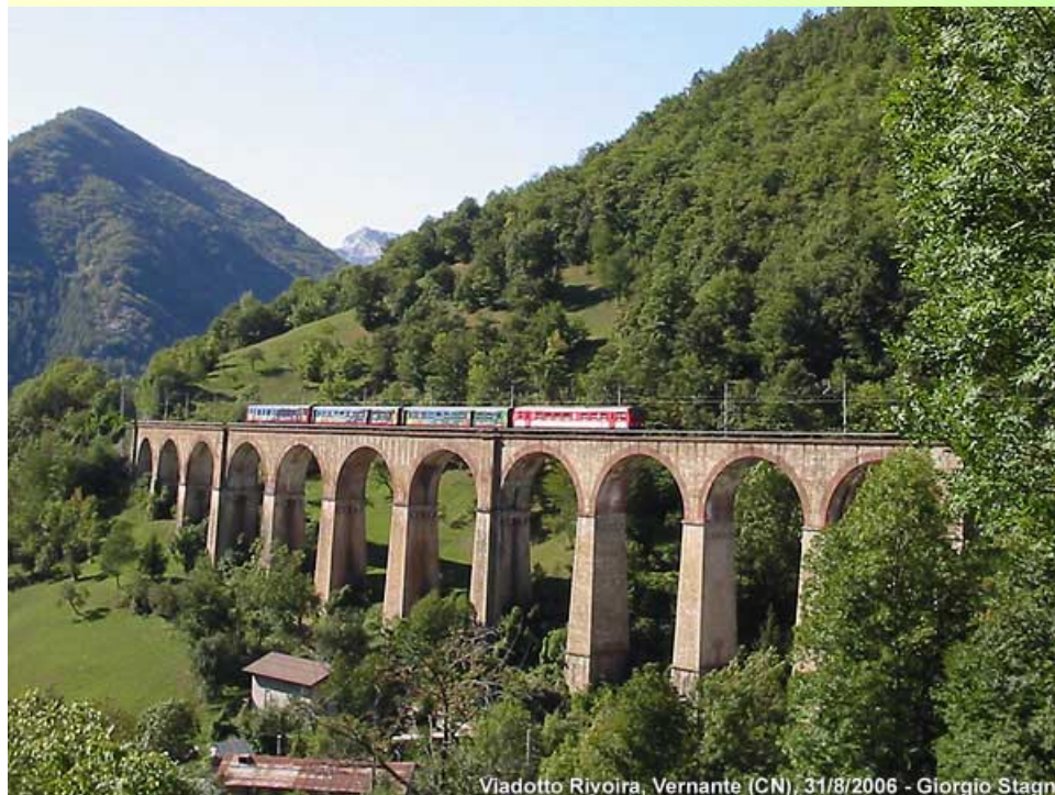
Viadotto Rivoira, Vernante (CN), 31/8/2006 - Giorgio Stagni
