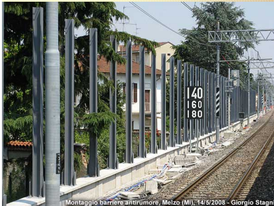
Montaggio delle barriere antirumore sulla Milano-Treviglio
