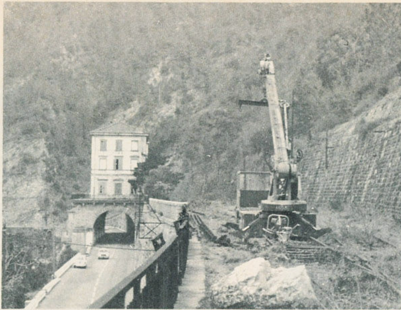
11-Dépose des anciennes voies à Piène en 1974 (Photo Braun)
