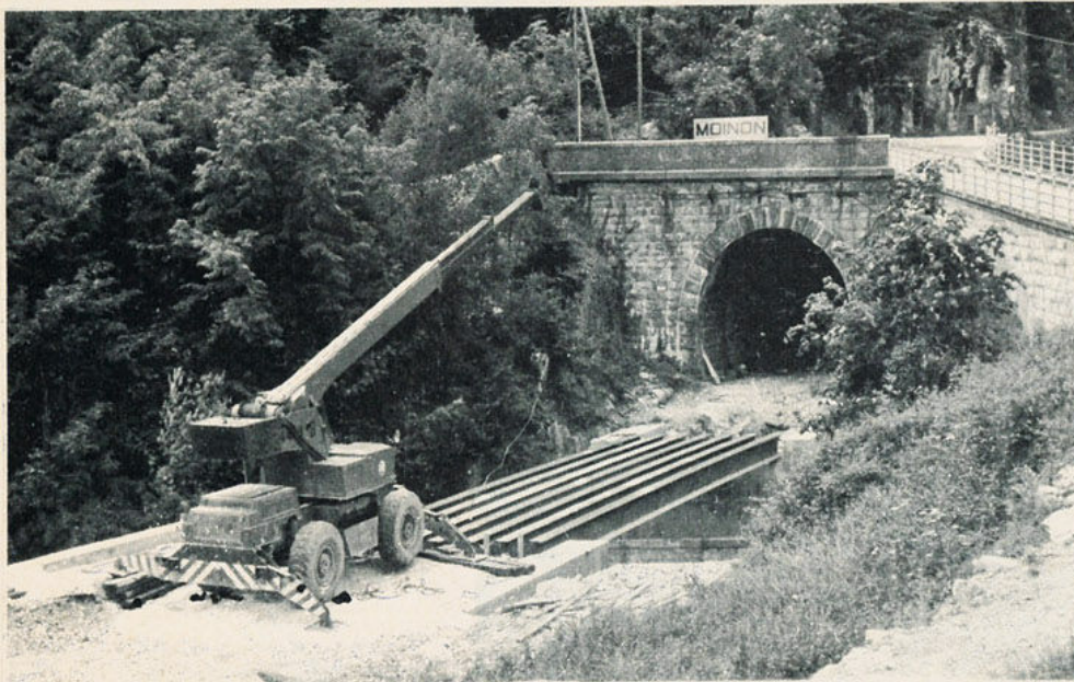
4-Le pont du vallon de la minière au PK 58,403 le 15-3-77 (Photo Braun)
