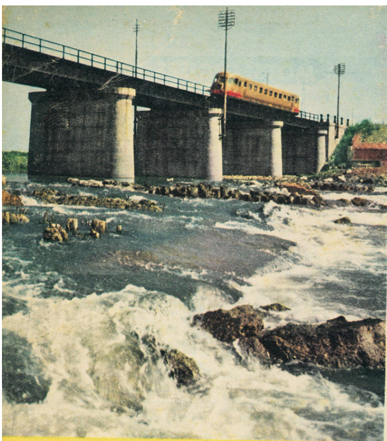
Sur la ligne Turin-Milan, un ouvrage d'art ferroviaire enjambe la Stara.
